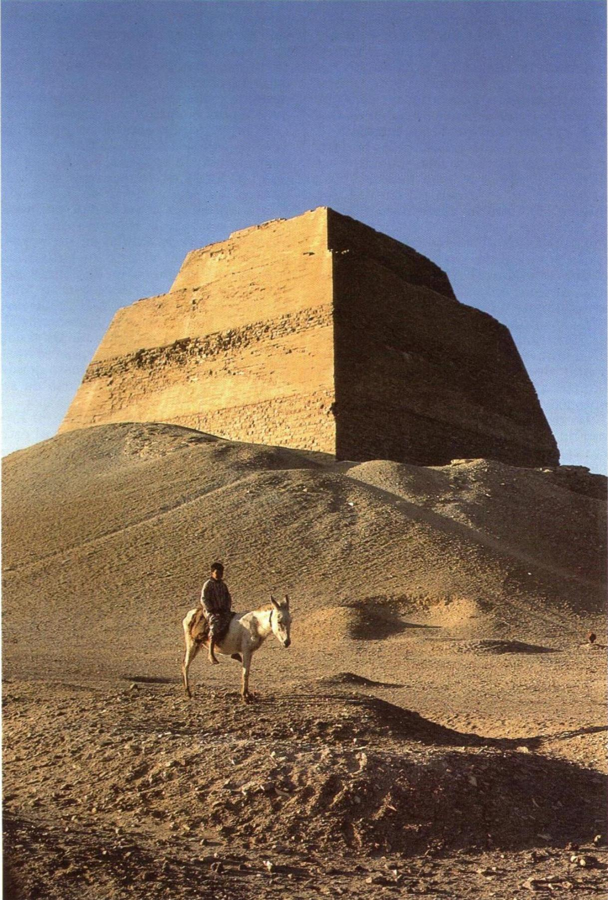
cuanto a forma y tamaño, pero el sistema de accesos y cámara sufrió varias rectificaciones, que se pueden reducir a tres fases. En la primera se construyó la entrada en el lado norte atravesando la masa piramidal y continuando a través de la roca con la sección acostumbrada de 1,09 m x 1,20 m y una longitud de 105,34 m, a partir de los cuales se torna horizontal y desemboca en la cámara funeraria, de 14,06 m x 8,36 m y una cultura variable de 3 a 4 m, cámara que quedó inacabada.
